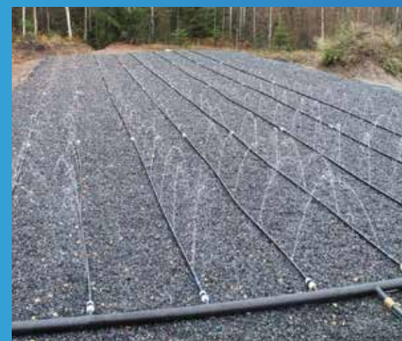
Manifoiler med 2, 3, 4 og 5 uttak. Det er laget med Ø110mm rør. Inntak er 50mm Uttak er 32mm.
