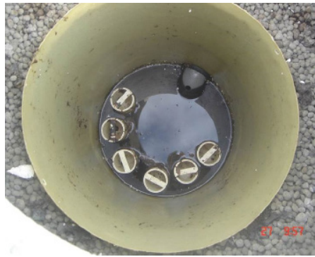
Figur 3. Fordelingskum med justerbare V-overløp. Foto: NIBIO.
